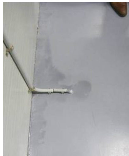
Figuur 5-14 Voorbeeld uitloop pigment.
