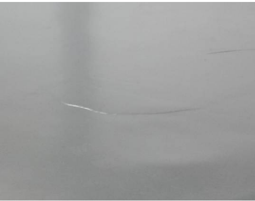
Figuur 5-6 Voorbeeld spaanslag.
